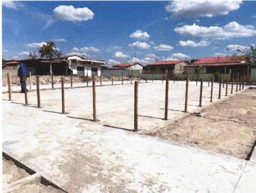
Foto 05- FORNECIMENTO E MONTAGEM DE CERCA DE PROTEÇÃO EM EUCALIPTO CLOEZIANA TRATADO A BASE DE CCA EM AUTOCLAVE, COM APLICAÇÃO DE STAIN NA COR NATURAL COM DUPLO FILTRO SOLAR, DIAMETRO DO EUCALIPTO DE 6 A 8 CM, COM ANTI-RACHA NA EXTREMIDADE. FECHAMENTO COM TELA DE ALAMBRADO FIO Nº 12 REVESTIDO DE PVC, MALHA 2.1/2 X 2.1/2", FIXADO COM FIO Nº 14 REVESTIDO EM PVC, MÓDULO MEDINDO 1,50 X 1,00M, PARAFUSOS GALVANIZADOS COM TRAVAMENTO CLICKFIX, CONFORME PROJETO
