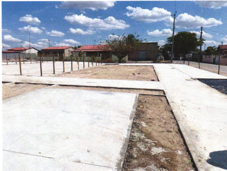
Foto 03 - PAVIMENTAÇÃO EM CONCRETO, COM ESPESSURA DE 7 CM, COM ACABAMENTO FEITO UTILIZANDO ALISADORA DE CONCRETO (HELICOPTERO), INCLUIDO TELA DE AÇO SOLDADA NERVURADA CA60, Q196 (3,11 KG/M 2 ), DIAMETRO DO FIO 5.0 MM, LARGURA = 2,45 M, ESPAÇAMENTO DA MALHA = 10 X 10 CM, JUNTA DE DILATAÇÃO EM PVC A CADA 2,00 M, CONCRETO FCK = 20 MPA
