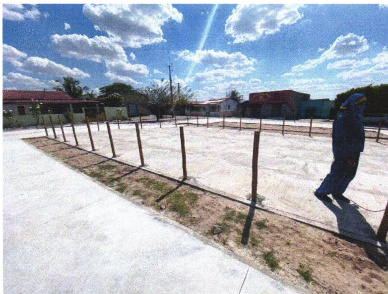
Foto 06 - FORNECIMENTO E MONTAGEM DE CERCA DE PROTEÇÃO EM EUCALIPTO CLOEZIANA TRATADO A BASE DE CCA EM AUTOCLAVE, COM APLICAÇÃO DE STAIN NA COR NATURAL COM DUPLO FILTRO SOLAR, DIAMETRO DO EUCALIPTO DE 6 A 8 CM, COM ANTI-RACHA NA EXTREMIDADE. FECHAMENTO COM TELA DE ALAMBRADO FIO Nº 12 REVESTIDO DE PVC, MALHA 2.1/2 X 2.1/2", FIXADO COM FIO Nº 14 REVESTIDO EM PVC, MÓDULO MEDINDO 1,50 X 1,00M, PARAFUSOS GALVANIZADOS COM TRAVAMENTO CLICKFIX, CONFORME PROJETO
